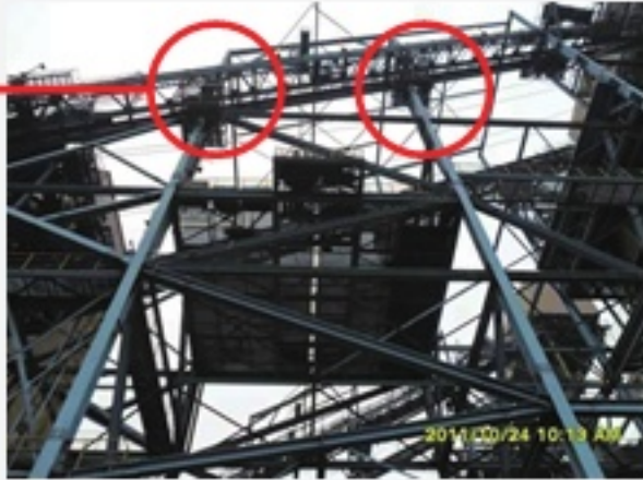
플랜트 공사 전경
