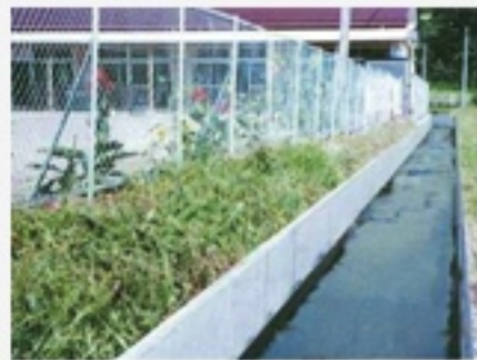
배수로커버 설치 전
