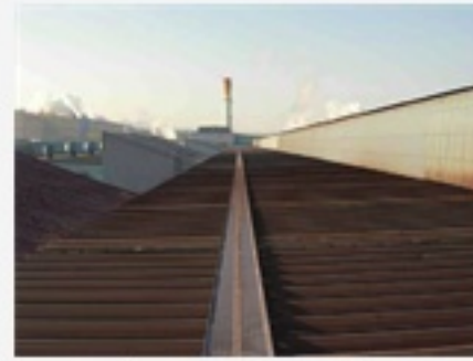
지붕 워커웨이 전경2
