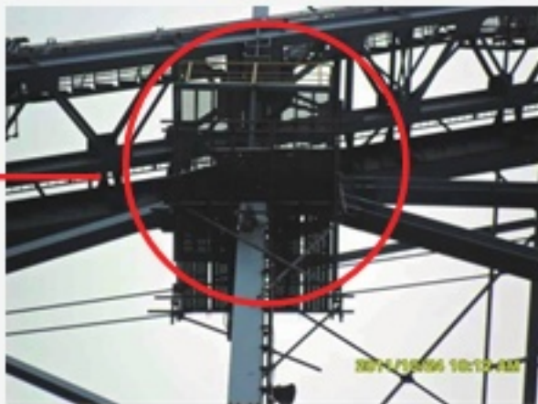
계단참 부분 교체작업 전경
