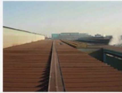
지붕 워커웨이 전경1
