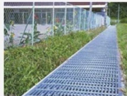
배수로커버 설치 후
