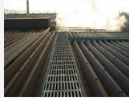
지붕 워커웨이 전경4
